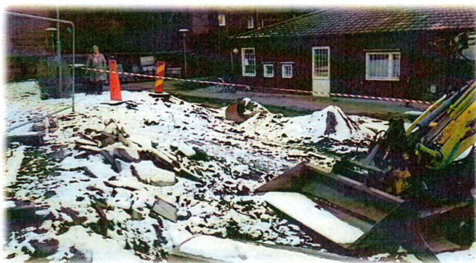
Arbetet med GMO – etapp 4 påbörjades under tidig vår 2015...
