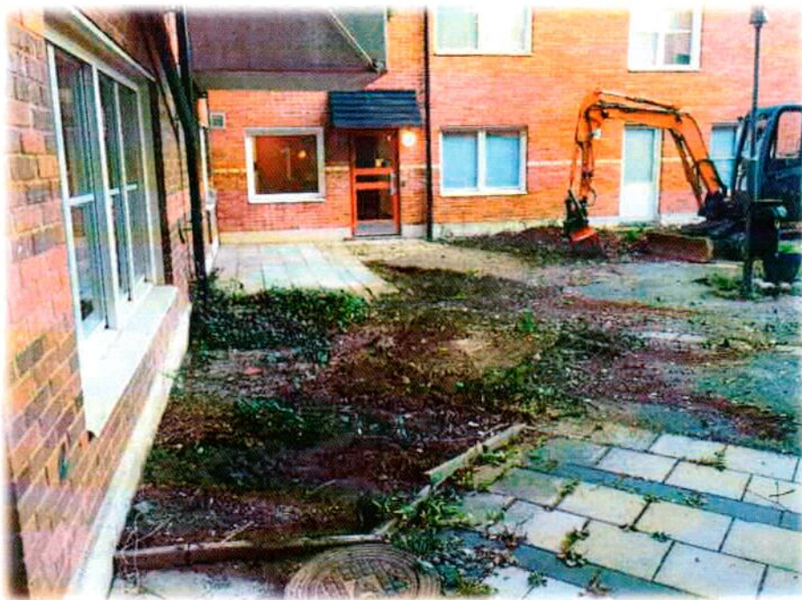
Befintliga markytor och staket rivs upp!
